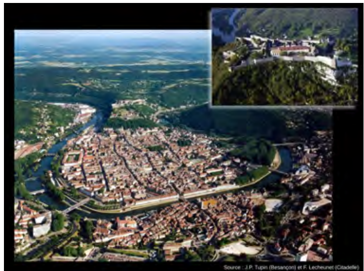
Figure 36 : Besançon vue du ciel : au premier plan, le quartier Battant. La Boucle apparaît au second plan surplombée par la Citadelle
